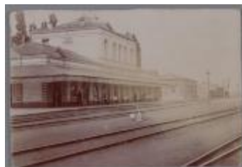
Lier, Station, Leopoldplein 34 (SLI001000636)
