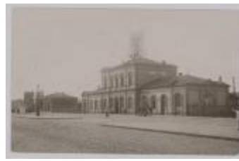
Lier, Station, Leopoldplein 34 (SLI001000630)
