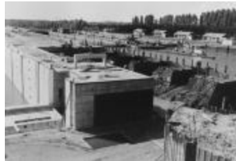
Bouw duwvaartsluis, Olen, 1974 (pvv_214)
