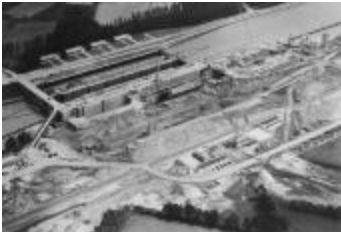
Bouw duwvaartsluis, Olen, 1973 (pvv_213)
