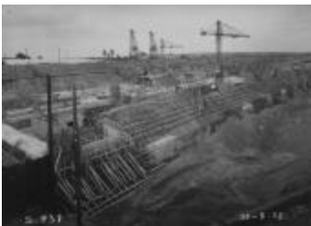
Bouw sluizen, Olen, 30 augustus 1938 (pvv_217)
