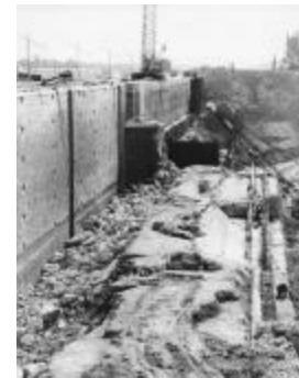
Bouw duwvaartsluis en afbraak kleine Sluis, Olen, 1973 (pvv_212)
