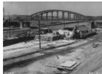
Brug over kanaal, Olen, 22 juni 1938 (pvv_219)
