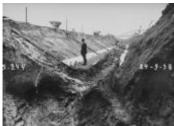
Graafwerken Albertkanaal, 24 september 1938 (pvv_240)
