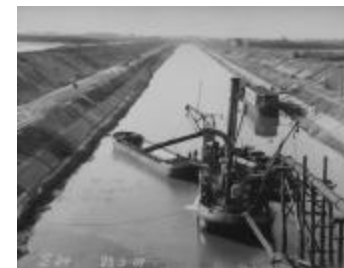
Graafwerken Albertkanaal, 23 september 1938 (pvv_239)
