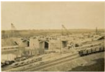
Bouw sluizen, Olen, 1935 (pvv_209)
