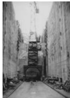
Bouw sluizen, Olen, 1938 (pvv_218)
