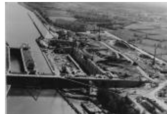
Bouw duwvaartsluis, Olen, 1973 (3) (pvv_211)
