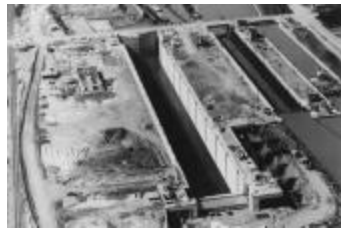
Bouw duwvaartsluis, Olen, 1973 (2) (pvv_210)
