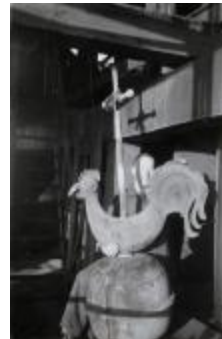
Lier, Dakwerken Leflot (SLI001035721)
