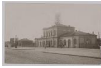
Lier, Station, Leopoldplein 34 (SLI001000630)
