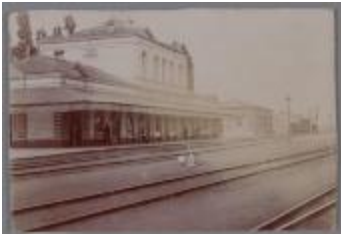
Lier, Station, Leopoldplein 34 (SLI001000636)
