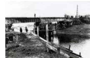
Lier, Ijzeren brug (SLI001033603)
