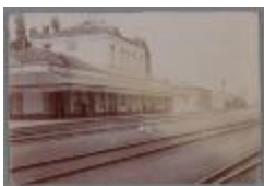
Lier, Station, Leopoldplein 34 (SLI001000636)
