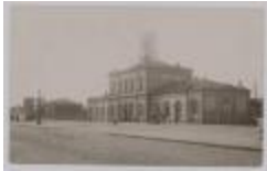
Lier, Station, Leopoldplein 34 (SLI001000630)
