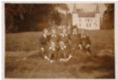
Gestel, Rameyenhof (DeSutter069)
